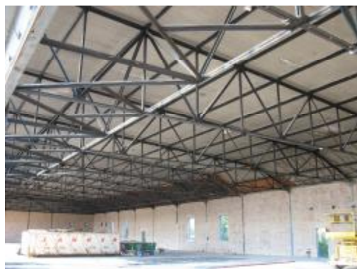
Die letzte erhaltene Normalflugzeughalle wird zur Reihenhausssiedlung umgebaut - Ergänzung zur anschließenden „Bergarbeitersiedlung“ (Zitat Winfried Roschmann) ?
