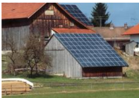
„Die durchgehende Dachdeckung mit Solarzellen für Photovoltaik verleiht dem kleinen Nebengebäude eine überzeugende Erscheinung“ (Landesverein für Heimatpflege). Das Gebäude steht in Rettenbach, ebenfalls Ostallgäu.
