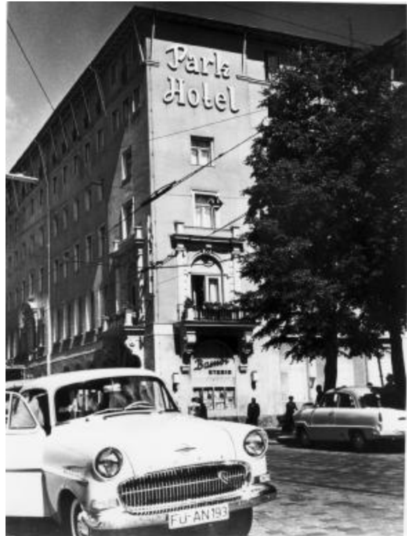
Das Parkhotel und der Eingang zur Rudolf-Breitscheid-Straße 1957 – ein stadtbildprägendes Gebäude. Foto: F. Vitzethum
