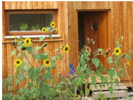
2007: Der erste Sommer im Holzlehmhaus
