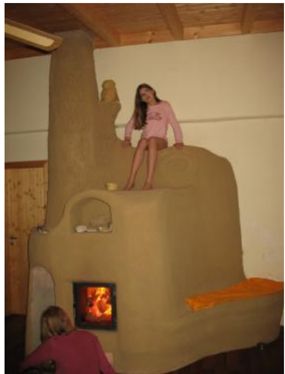
Der mit Lehm verputzte Grundofen, Gewicht ca. 5 Tonnen, heizt zusammen mit Solarenergie das Haus und bereitet Warmwasser
