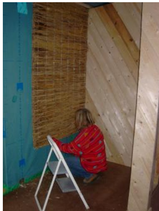
Aufbringen der Strohmatte als Isolierung und Lehmputzträger
