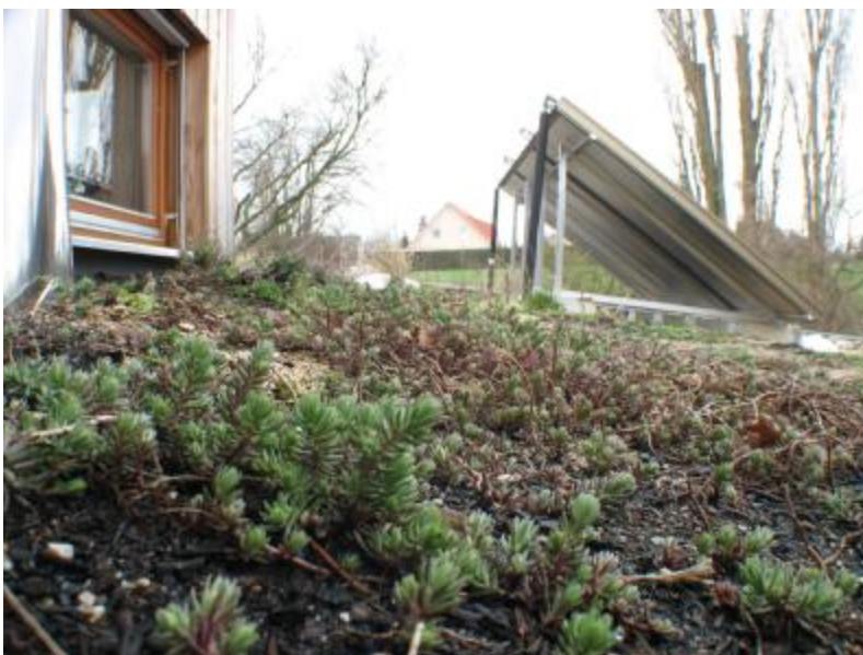
Vegetation auf dem Dach, hier Mauerpfeffer, im Hintergrund Hauswurz und Lavendel zur biologischen Schnakenabwehr.
