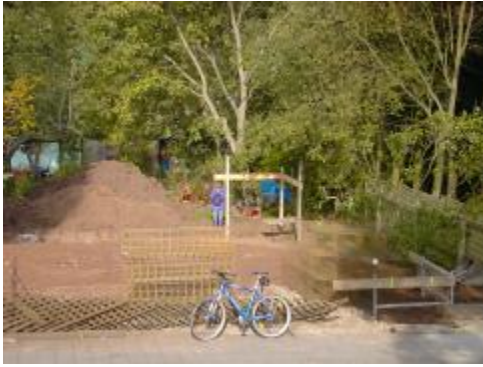
Beginn der Fundamentarbeiten
